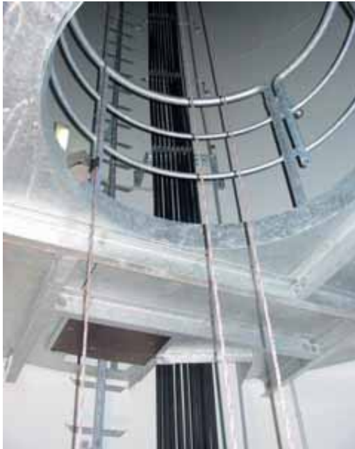
Brüstung zum Schutz gegen Absturz
