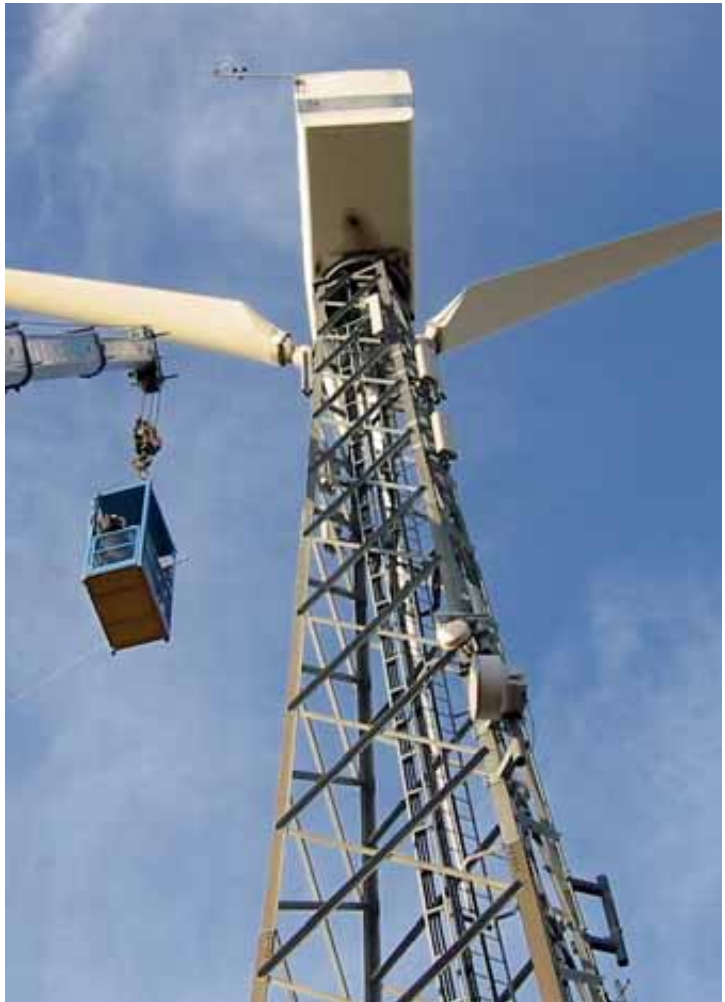
Funkantennen an einer WEA
